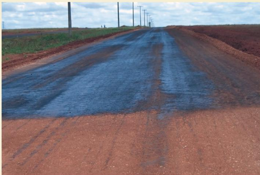
Figura 7 - Imprimação da base RCD
