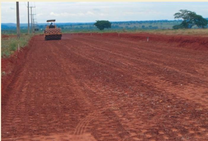
Figura 5 - Compactação do RCD
