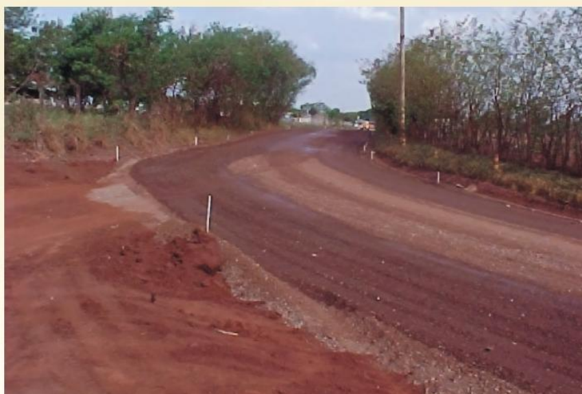
Figura 1 - Execução da pista com RCD
